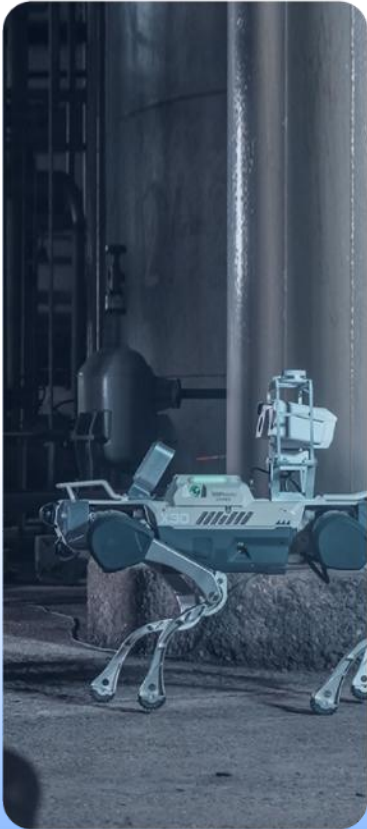
Inspección de la central eléctrica
